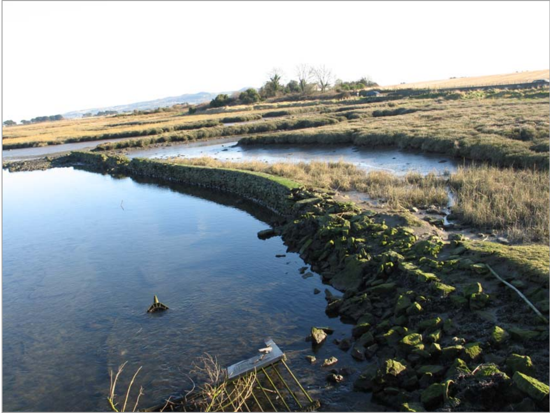
12. Mill pond revetment
